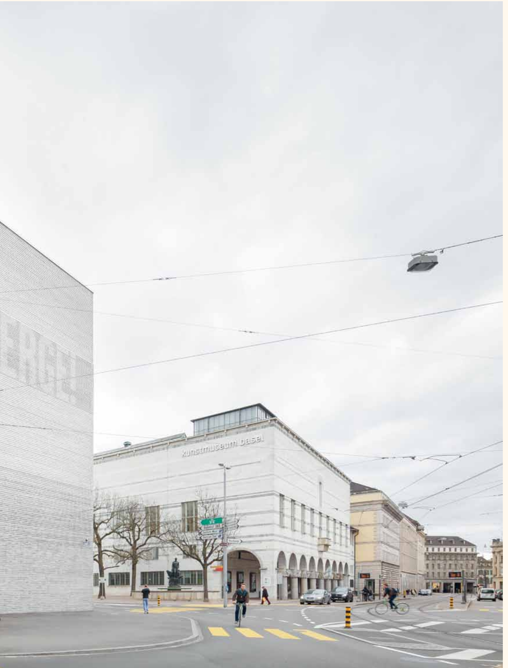
Kunstmuseum Bâle, façade brique avec éclairage LED intégré réalisée par Iart, Bâle
